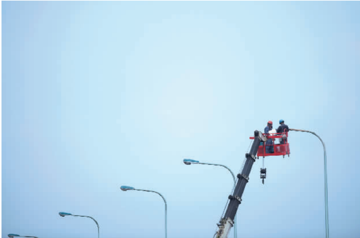
昨天,天气炎热,在市区中环南路,电力工人冒着高温在修路灯。
